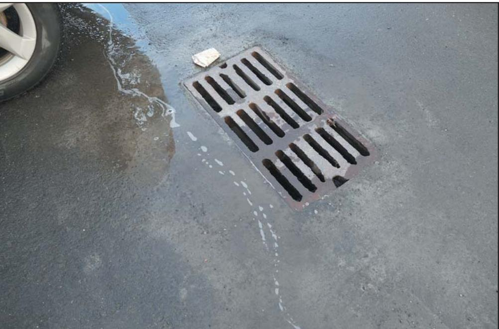
Водоприемные решетки ливневой канализации оказались устроены таким образом, что дождевая вода в них не попадает, проходя струей мимо. На фото видно, как поток огибает ливневый приемник, устремляясь далее формировать лужу. Иными словами, ливневый коллектор на бульваре фактически не работает. И, скорее всего, этот изъян по-простому не исправить.
